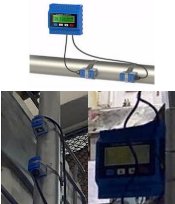
4.4 Сурет – TUF-2000M ультрадыбыстық шығын өлшегішін орнату үлгісі
