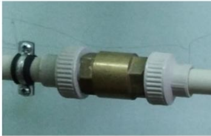
4.9 Сурет – Кері клапан
